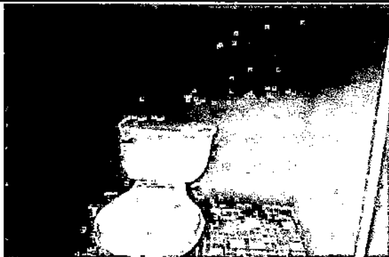
Foto 3: Sustitución de inodoro
